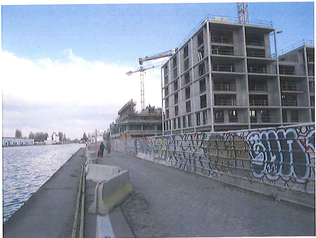
Première phase de construction des logements (lots 2 & 3) – DRIEE, Mars 2015
