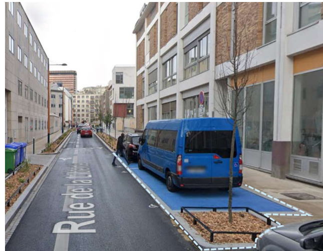
Gestion du stationnement/arbre à l'égale de la rue de la Liberté
