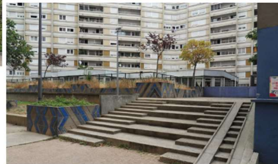
④ Des cheminements difficiles au sein de la dalle.
