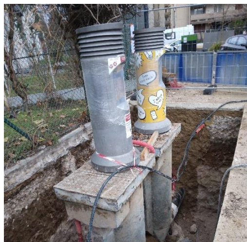
Figure 7 : Photos du chantier du n°1 rue des Fontaines
