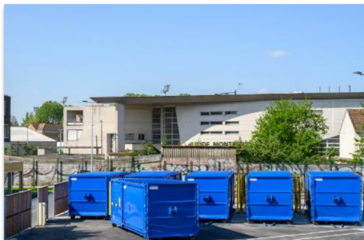
Figure 24 : Caissons compacteurs à la déchèterie de Montreuil
