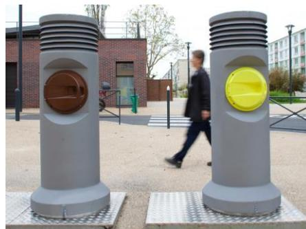
Figure 7 : Bornes de collecte par aspiration pneumatique
