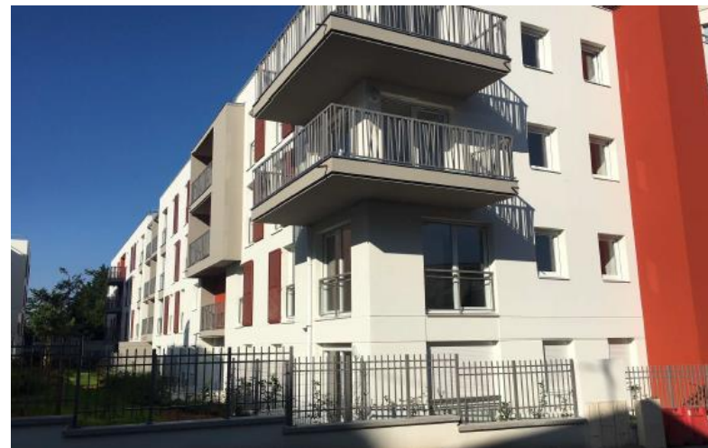
KREMLIN BICETRE (94) Résidence Pierre Séward 51 logements
