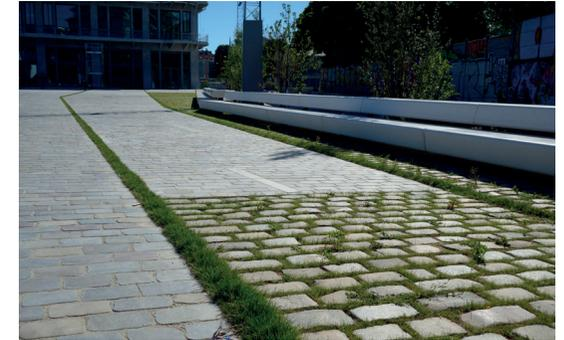
→ Les pavés enherbés limitent et ralentissent les écoulements malgré de faibles capacités d'infiltration.
