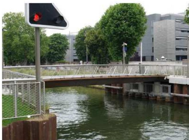
Figure 120 : Exemples d'intégration de passerelles mobiles
