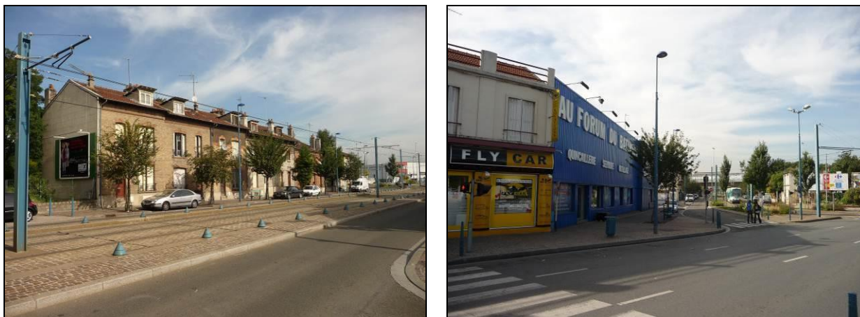
Photo 35 : Bâtiments de l'extrémité Nord de l'avenue Gallieni situés dans les secteurs dit des Triangles de l'Ourcq (Photos : Asterra, 2011)
