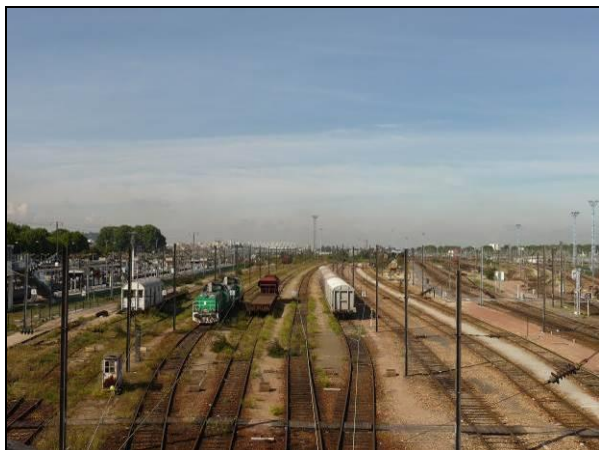
Photo 49 : La gare de triage SNCF (Photo : ASTERRA, 2011)
