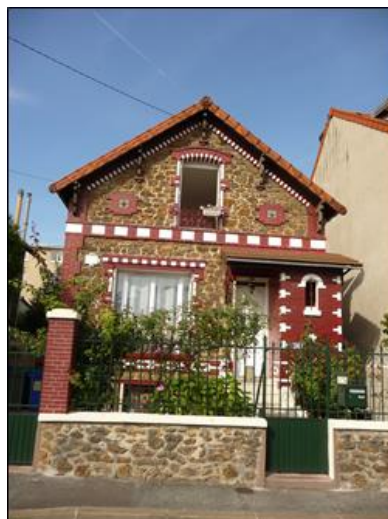
Photo 45 : Pavillon en meulière situé avenue Burger
