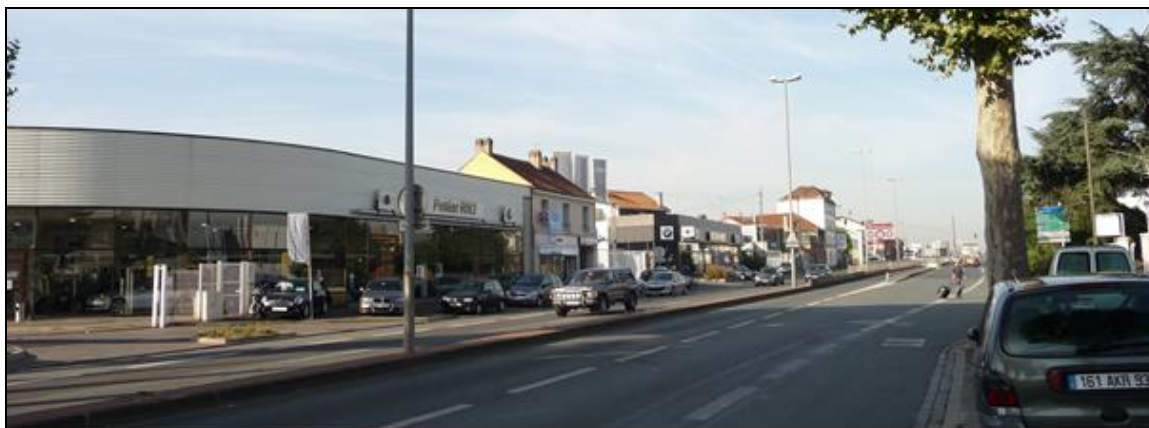
Photo 15 : Front urbain sur l'ancienne RN3 au niveau du secteur de La Passementerie (Photo : Asterra, 2011)
