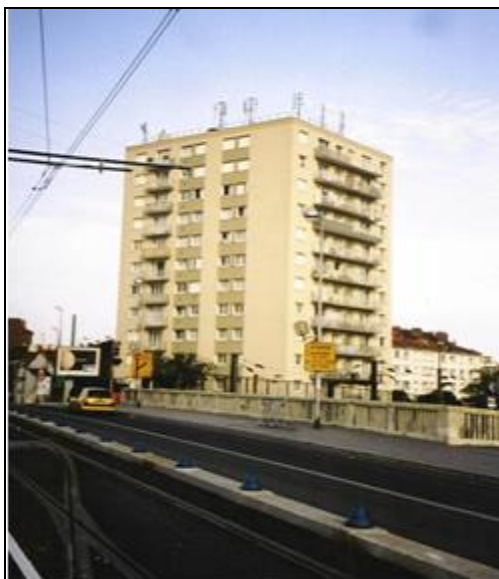
Photo 7 : Immeuble des années 1960 (Source : Ozone, étude logement - habitat - cadre de vie au Petit Noisy, novembre 2003)
