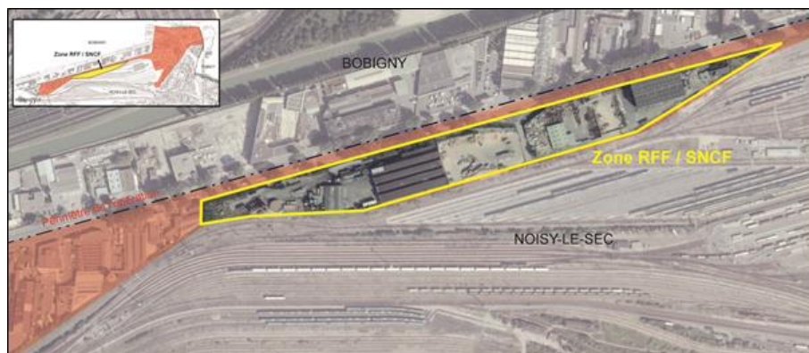
Figure 57 : Occupation du sol sur les emprises de la SNCF (RFF) le long de l'ancienne RN3 (Illustration : Asterra, source photoaérienne : Géoportail)
