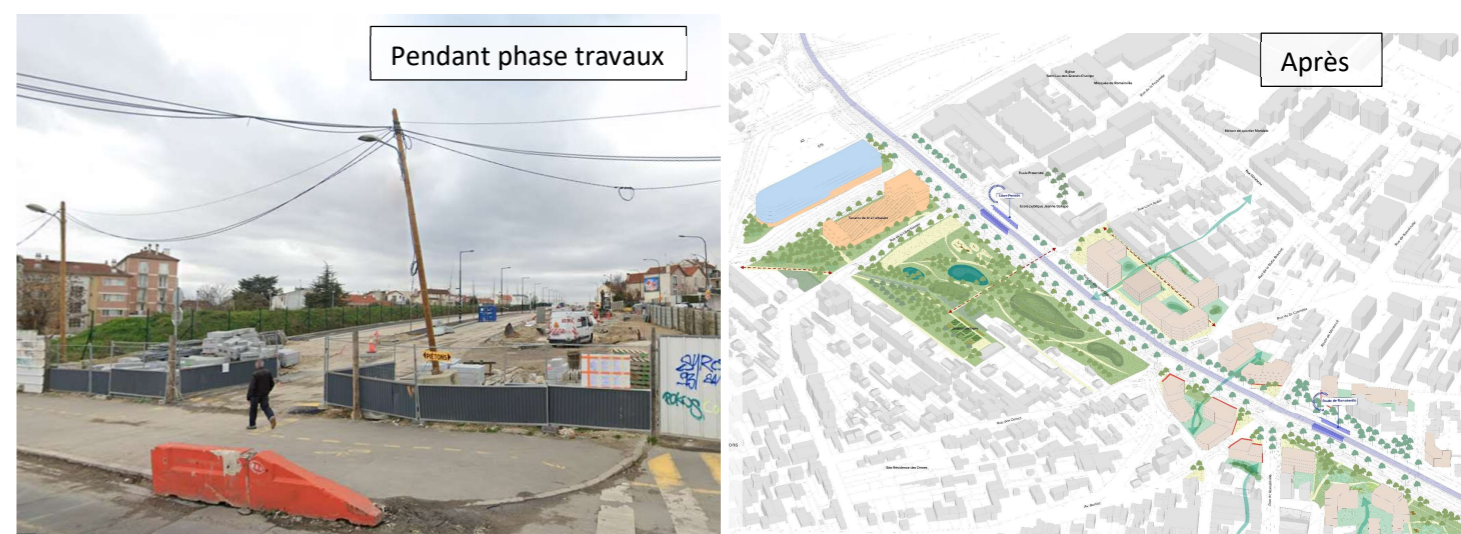
Photographie de l'évolution des travaux (Google Street View et Montreuil.fr, 2023)
