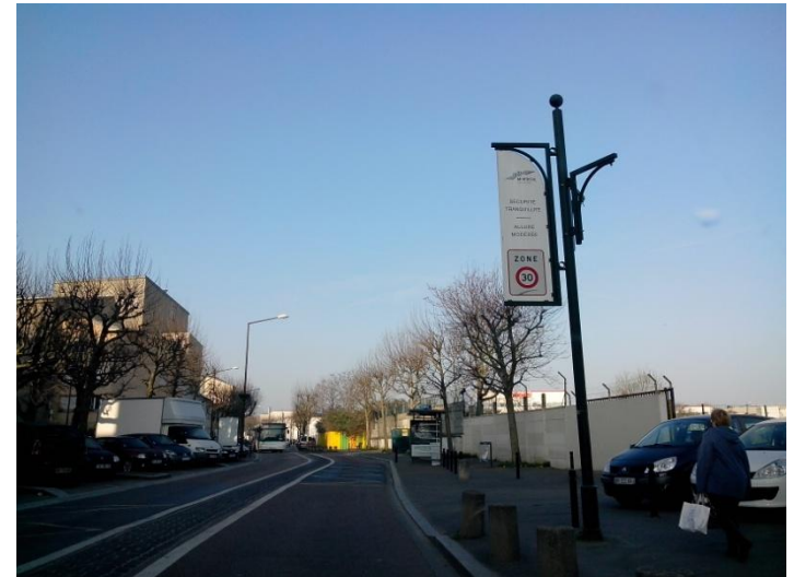
Une entrée en zone 30 avec voies séparées par un terre-plein central
