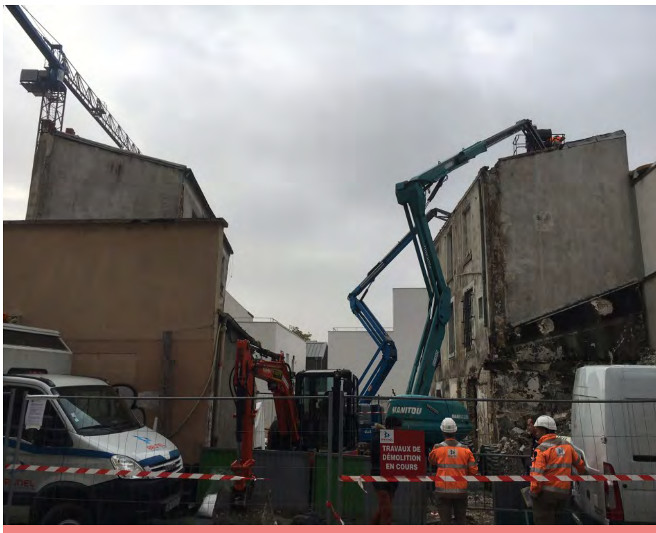
Démolition d'une copropriété insalubre au Pré Saint-Gervais.
