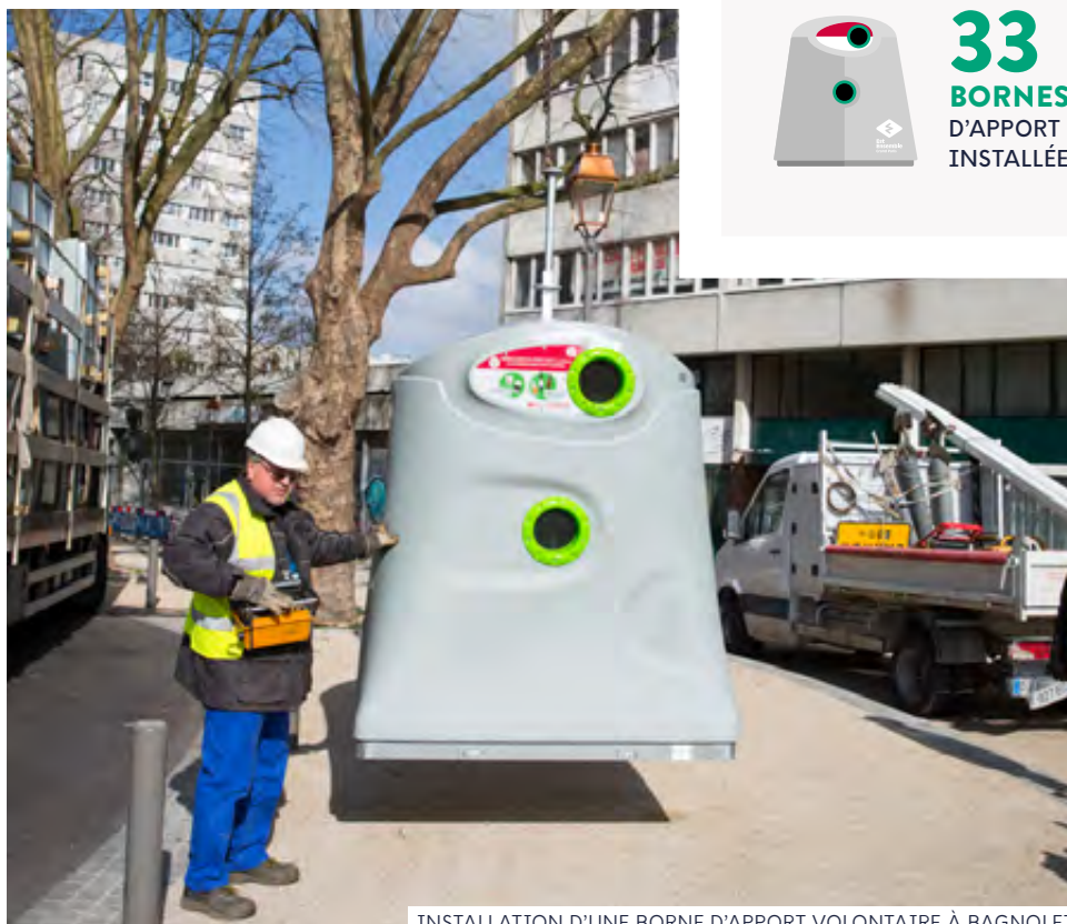
INSTALLATION D'UNE BORNE D'APPORT VOLONTAIRE À BAGNOLET.
