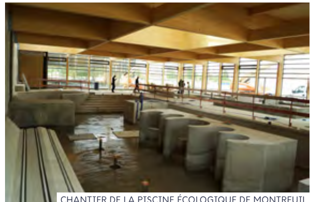
CHANTIER DE LA PISCINE ÉCOLOGIQUE DE MONTREUIL.
