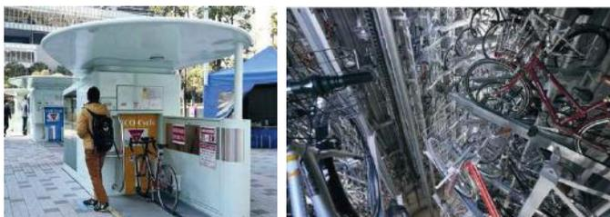
Chaque parking vélo est creusé à 11 mètres de profondeur et permet le stationnement de 204 vélos. Les cycles seraient sécurisés par contrôle d'accès (exemple Pass Navigo) avec environ 15 secondes pour que le vélo soit restitué.
