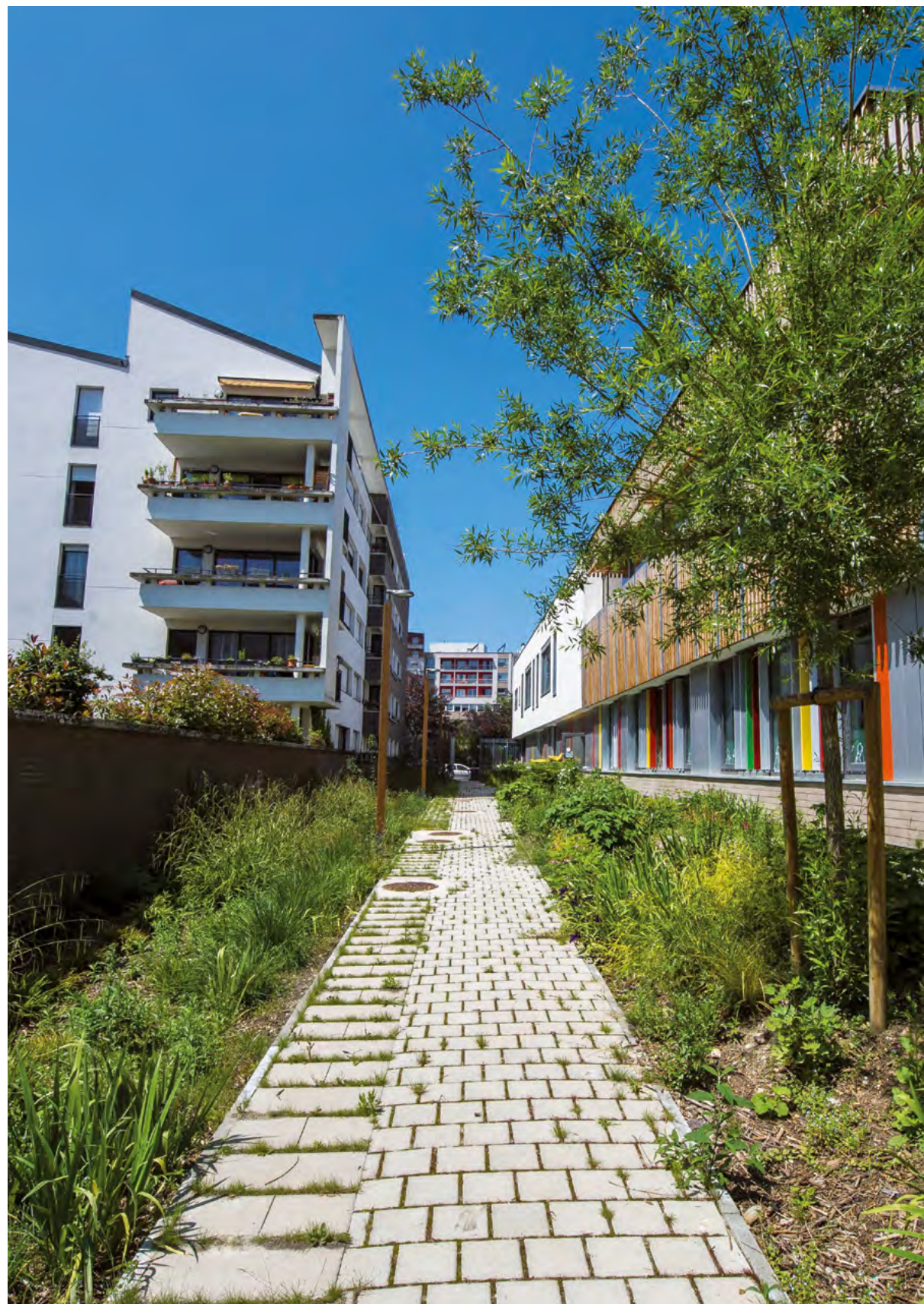
SQUARE DE LA RÉSISTANCE, MONTREUIL Pavés enherbés et noues permettant de réduire le ruissellement.
