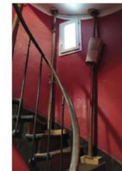
ETAIEMENT DE LA VOLÉE R+2- R+3
