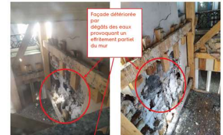
ETAIEMENT FAÇADE SINISTRÉE
