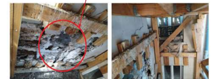
ETAIEMENT FAÇADE SINISTRÉE
