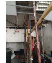
ETAIEMENT DU PLANCHER HAUT RDC
