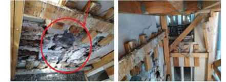
ÉTAIEMENT FAÇADE SINISTRÉE
