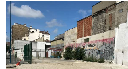
6 . AP 52 , 53 rue des Sept Arpents : parcelles traitées par la Ville et la Soreqa, occupés autrefois par de l'habitat insalubre et dégradé.
