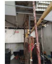
ÉTAIEMENT DU PLANCHER HAUT ROC
