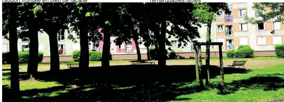
Les équerres - Arbustes en pieds de bâtiments et arbres en port libre au milieu de pelouses
