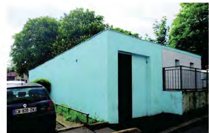
Détournement d'usages des locaux communs comme salle de musculation
