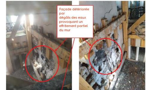
Façade détériorée par dégâts des eaux provoquant un effritement partiel du mur
