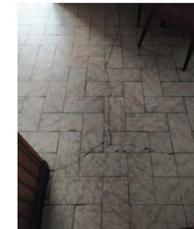
FISSURES SUR LE PLANCHER BAS DU RDC
