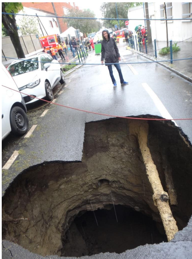
Photo 3 : Exemple d'un fontis de carrière de gypse de 1ere masse à Pantin (2016)
