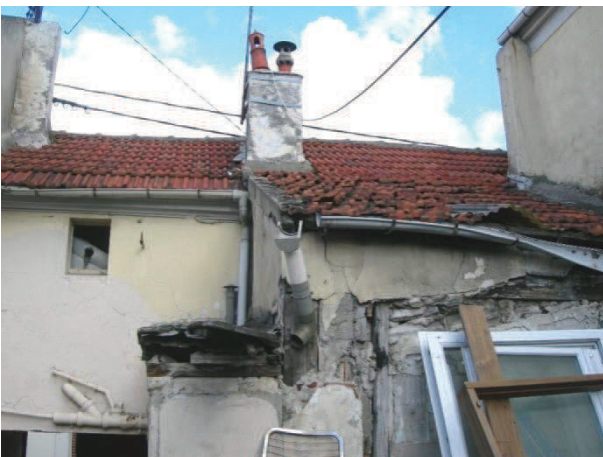
► Une partie de la couverture s'est effondrée.
