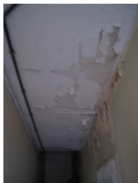
► Fort taux d'humidité dans les circulations.
