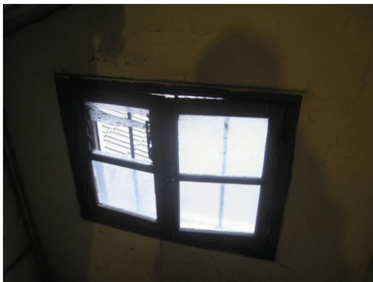
► Menuiseries des parties communes hors service
