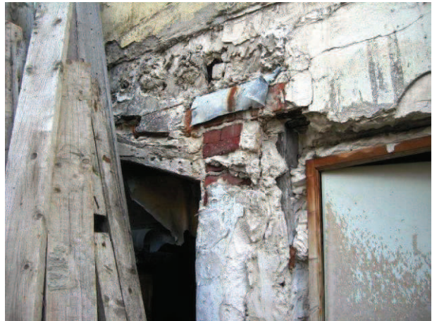
► Chute d'enduit et de maçonnerie. Au niveau de point sensible de la structure
