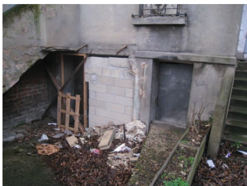
Vue du bâtiment rue depuis la cour - Zone de structure faible (escalier et plancher)
