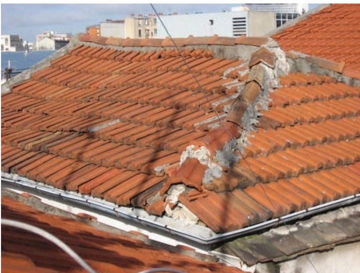
Toiture dégradé du bâtiment A depuis le 3 rue Rapatel.
