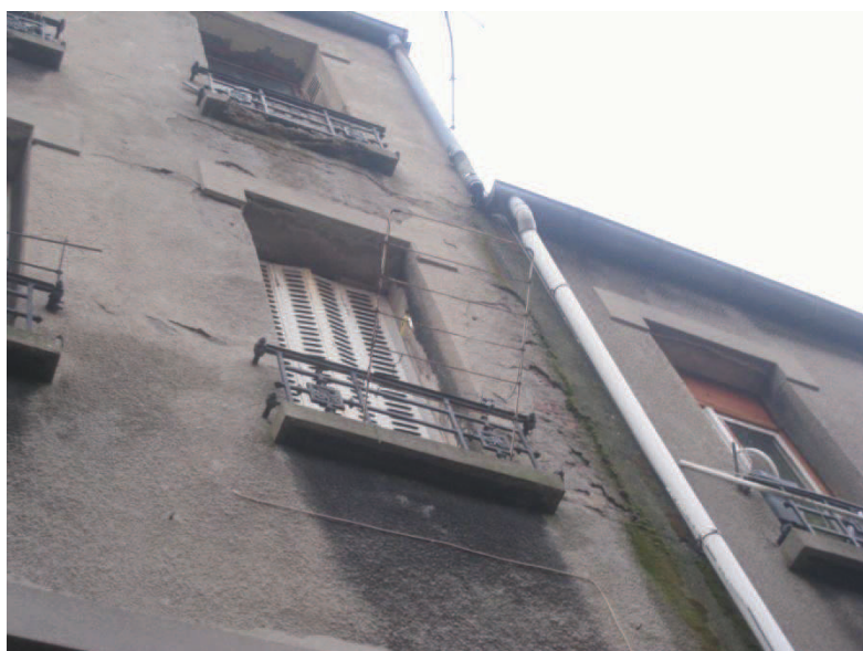
► Rives de toiture et souches de cheminée fuyards
