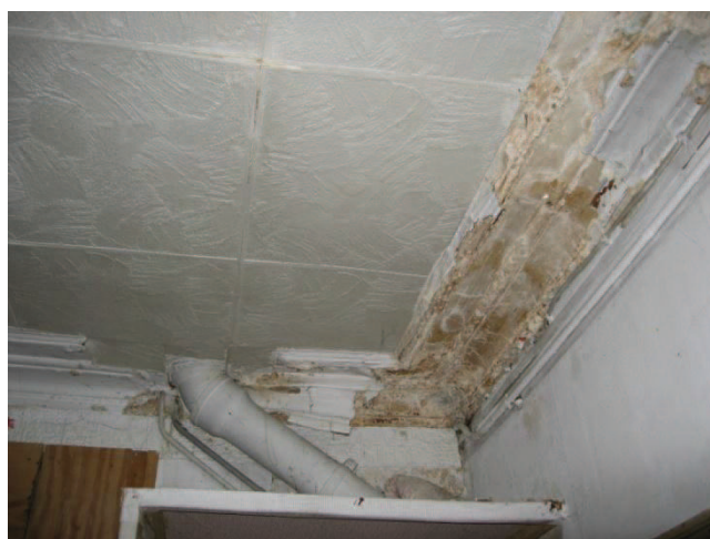
Traces d'humidité sur plafond dans un logement – 1 er étage bâtiment A.
