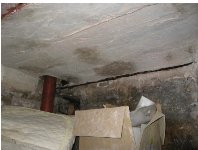
Tirants métalliques rouillés et traces d'humidité – cave bâtiment A.
