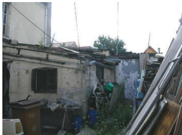
► Evacuation pluviale manquante, toiture affaissée et cour encombrée.
