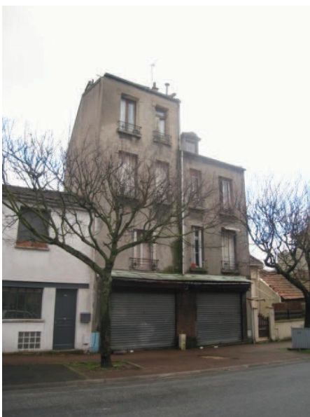
Façade rue de Romainville, en enduit ciment, en mauvais état.
