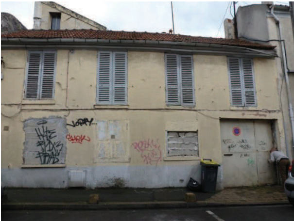
► Façade rue, en mauvais état avec le RDC muré.
