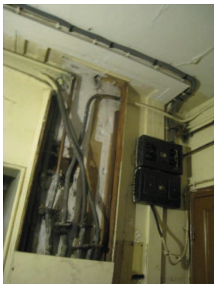
► Réseau gaz en plomb obsolète.
