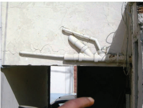
► Pente trop faible des évacuations d'eau vanne avec des points fuyards.
