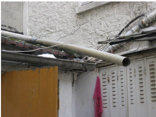
Divers réseaux désorganisés – extension sur cour.
