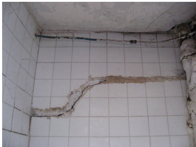
Dégradation des EP et faïence – WC communs sur cour.
