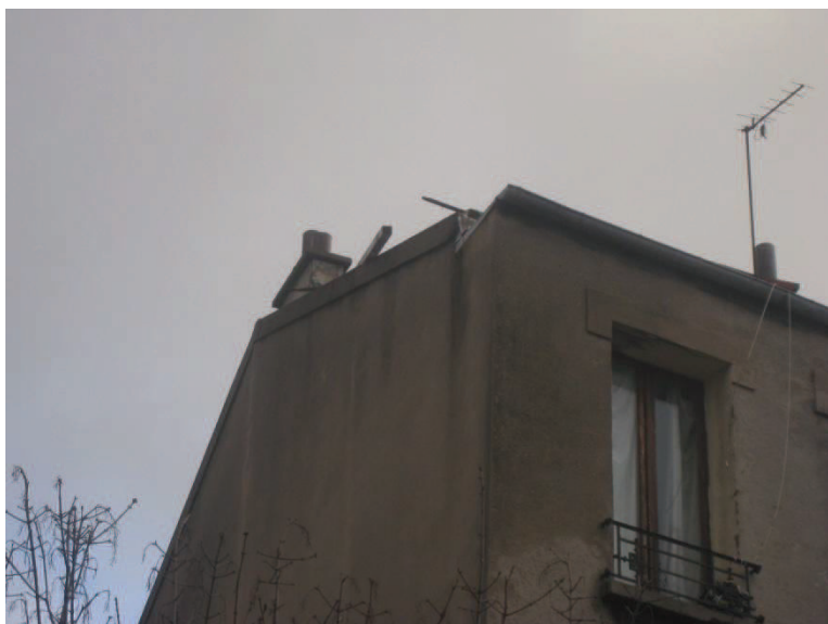
► Rives de toiture et souches de cheminée dégradées
