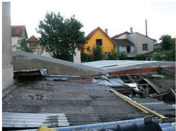
► Organisation des couverture anarchique avec de la tôle ondulée amiantée.
