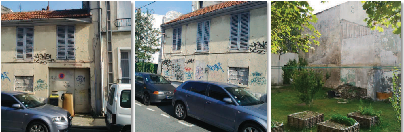
► Photographies du bâti
