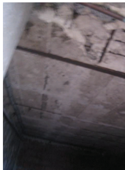
► Plancher des caves en mauvais état.
