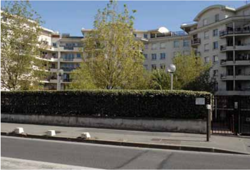
Résidence de collectifs boulevard de la Boissière (sur la commune de Rosny-sous-bois)
