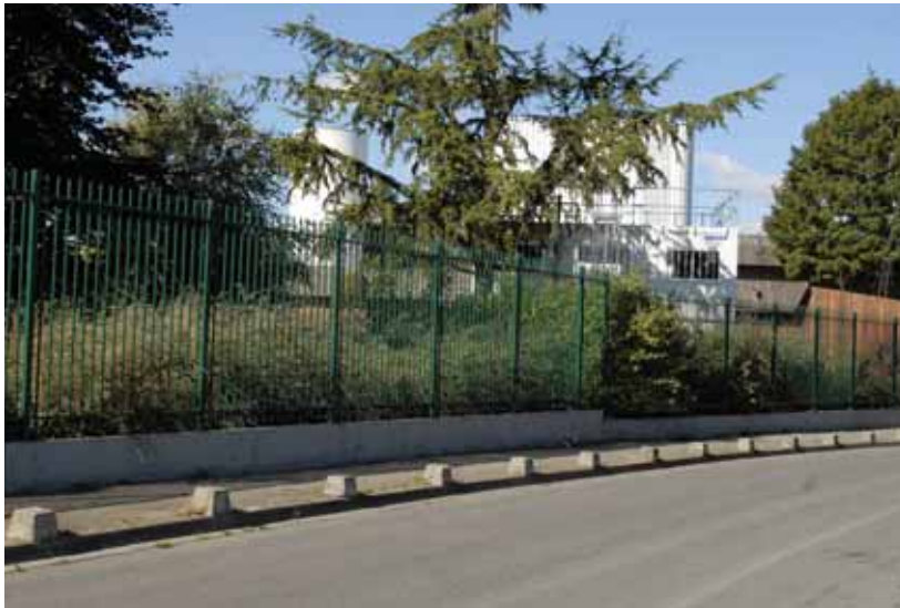
Le site du SEDIF et ses réservoirs, rue de la Montagne Pierreuse.
