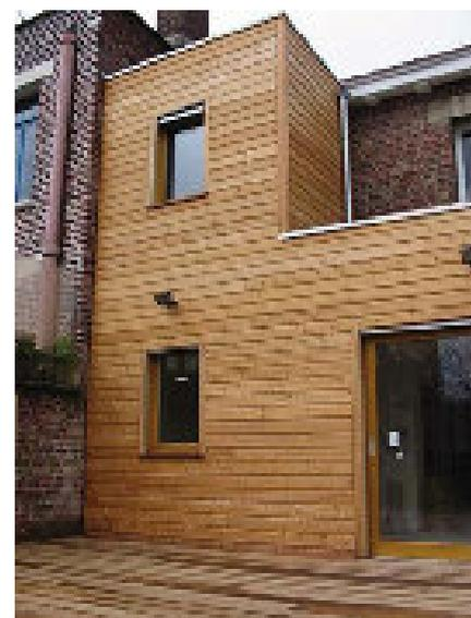
L'extension de la maison en briques est recouverte d'un parement en bois (mélèze).
