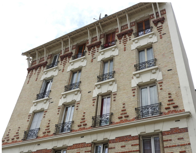
Immeuble du début XX e siècle avec une architecture régionaliste en briques très claires (crème) en parement et briques rouges plus ou moins saillantes* en décor et des linteaux* et des bandeaux* enduits.
