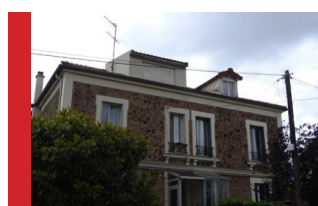
Exemples de lucarnes de types et de matériaux variés.
