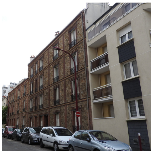
Bondy : cet immeuble récent à droite vient difficilement s'insérer dans le paysage urbain car il n'est pas du tout en lien avec son environnement et ne dialogue pas avec des voisins direct : aucune accroche ne les lie : proportions, rythme des baies, matériaux...
