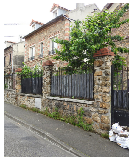
Mur bahut en meulière et grilles en fer forgé pourvues de pare-vues*. Le mur bahut est agrémenté de potelets couronnés de briques.
