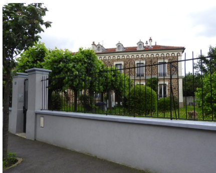
24, rue Phileas Collardeau - Très bel immeuble de rapport. Il est dommage que la clôture ait été peinte de façon uniforme, elle n'est pas en adéquation avec le bâti remarquable et la typologie des clôtures.
