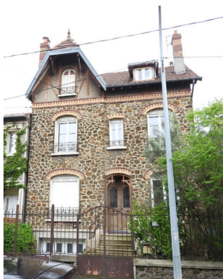
17 rue du Lion - Grande demeure de type régionaliste avec avant-corps suggéré par la toiture - Mur pignon* en alternance de briques rouges et jaunes de très belle facture.
