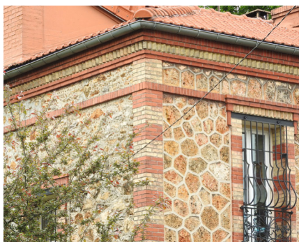
D'une façade à l'autre le traitement de la meulière peut être différent. Encadrements, chaîne d'angle et bandeaux et corniche en briques
