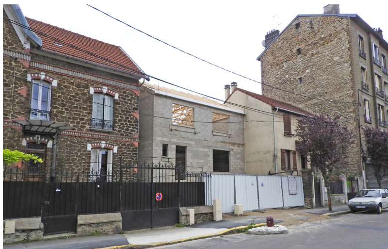
Vue des travaux en cours en 2016.
