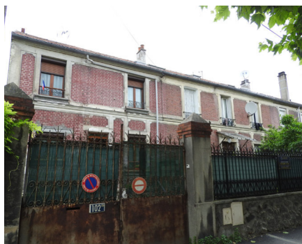
Maison en bandes identiques avec enduit de briques teintées.
