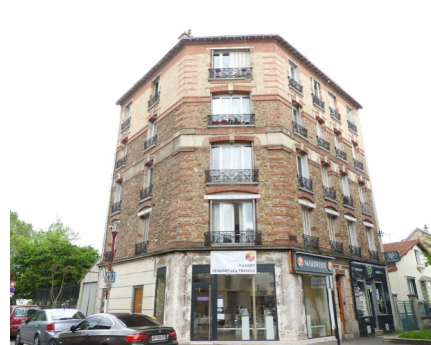
Immeuble voisin de l'église très travaillé en maçonnerie enduite au RdC, étages courants en meulière et dernier étage en brique.
