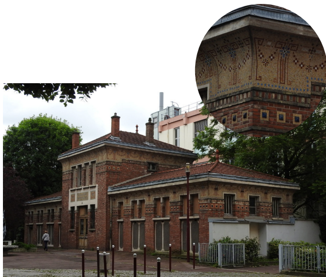
Place du 8 mai - Les bains douches - Années 20/30. Le bâtiment est en bon état hormis quelques menuiseries disparues. Sa restitution devra prendre exemple sur les menuiseries anciennes en place pour ne pas dénaturer l'esprit des bâtiments.
