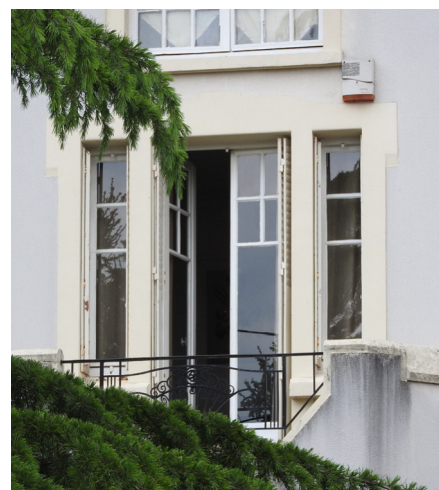
Trois beaux exemples de menuiseries d'origine conservées et qui participent à la richesse architecturale du bâtiment et de la ville, notamment par la variété des mises en œuvre des petits bois. Contrevents* métalliques persiennés* repliés en tableau.
