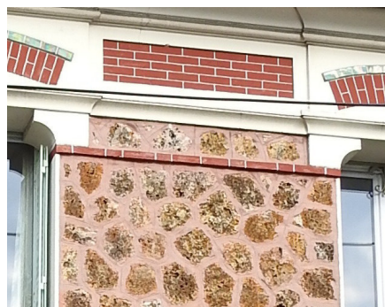
Exemple de joint de couleur rosé. Décors en enduit et briques
