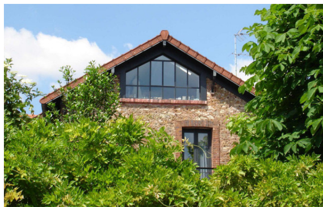
Bel exemple de baie et de menuiserie contemporaines intégrées sur le mur pignon d'une maison en meulière traditionnelle.
