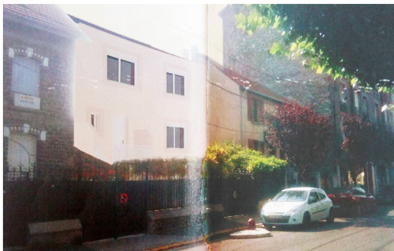
Vue de l'insertion de la maison dans le paysage urbain, extrait du Permis de Construire.
