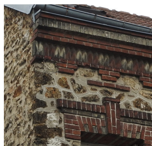
Type de corniche* en briques assez courant.
