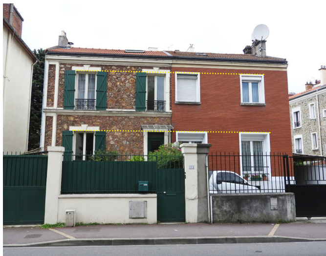
Bondy : construction des années 1950 respectant le rythme des ouvertures et les proportions de la maison voisine.
