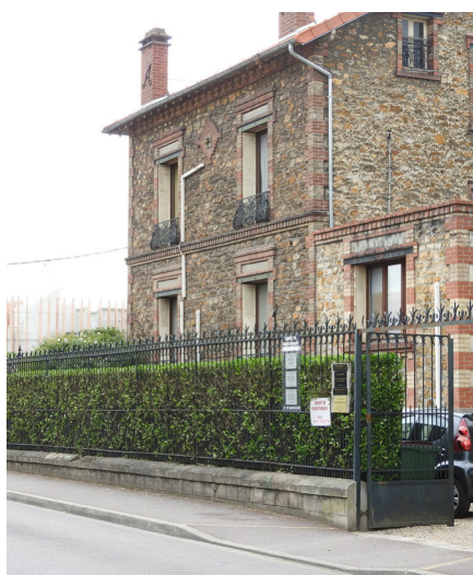
Mur bahut bas, en béton, donnant une place importante aux grilles en fer forgé.
