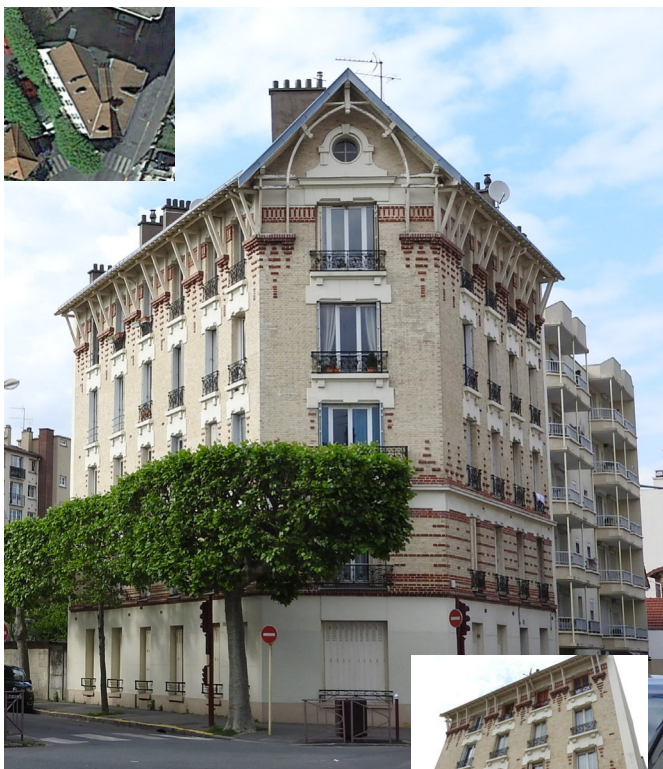
Très bel immeuble dont le style s'inspire de belles demeures bourgeoises et que la position urbaine met en valeur. À noter que les menuiseries ne sont plus identiques à tous les niveaux, cela fait perdre en cohérence.
