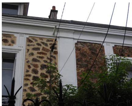
Maison jumelle : le parement ancien à droite est beaucoup plus esthétique que celui de gauche restauré avec un joint plus clair et trop «beurré» (il masque la pierre).
