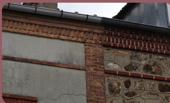
À gauche meulière recouverte de ciment et à droite joint au ciment beaucoup trop larges et masquant une trop grande partie de la pierre.
