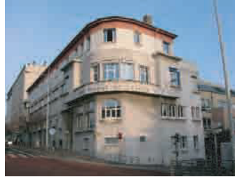
Photo Dép. de la Seine-Saint-Denis, M.F. Laborde
