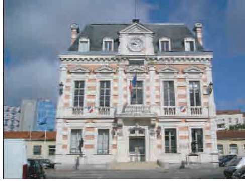
Photo : Dép. de la Seine-Saint-Denis, M F. Laborde
