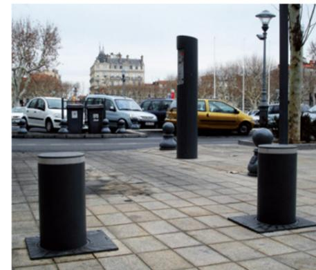
Exemple de bornes escamotables électro-pneumatiques
