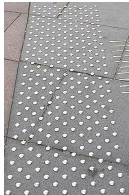
Principe d'installation de clous inox podotactiles sur revêtement en dalles calepinées
