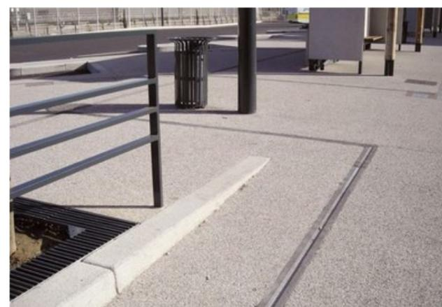
Exemple d'utilisation d'un profil en creux en béton comme rail de guidage
