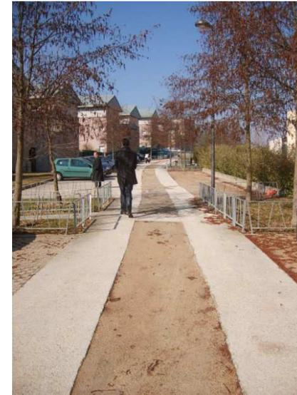
Stabilisé compacté mécaniquement
