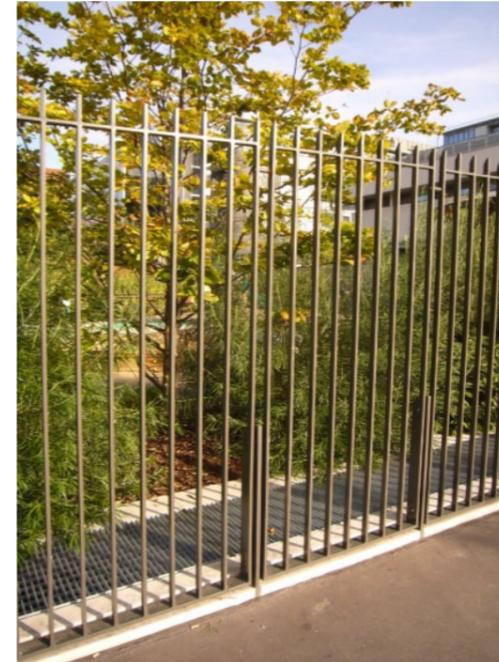
Exemple d'une clôture composée de barreaudages fins montés sur des cadres et de poteaux courts de même section
