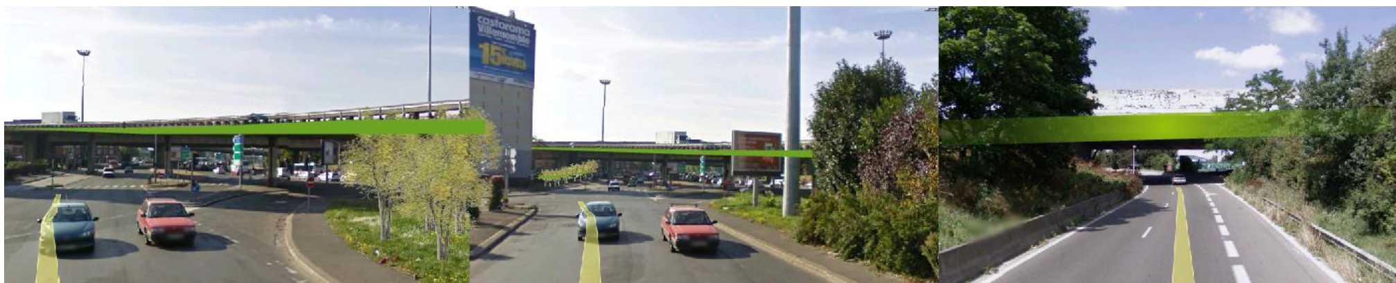
Vues sur le pont de l'A3 à Bondy
