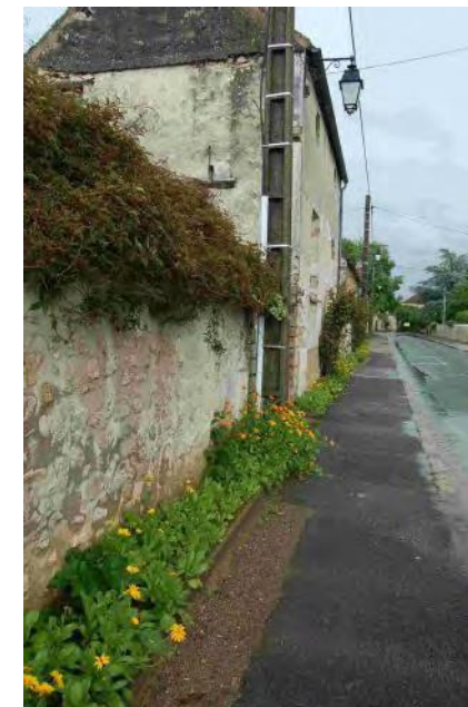
Pied de mur végétalisé (Dannemois).
