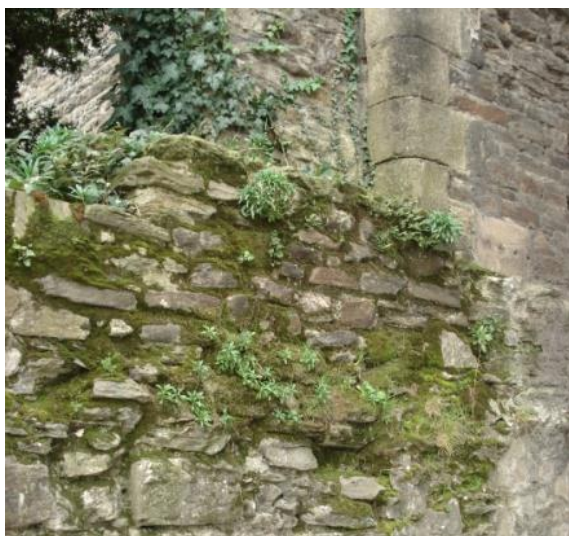
Mur en pierre colonisé par la végétation spontanée.
