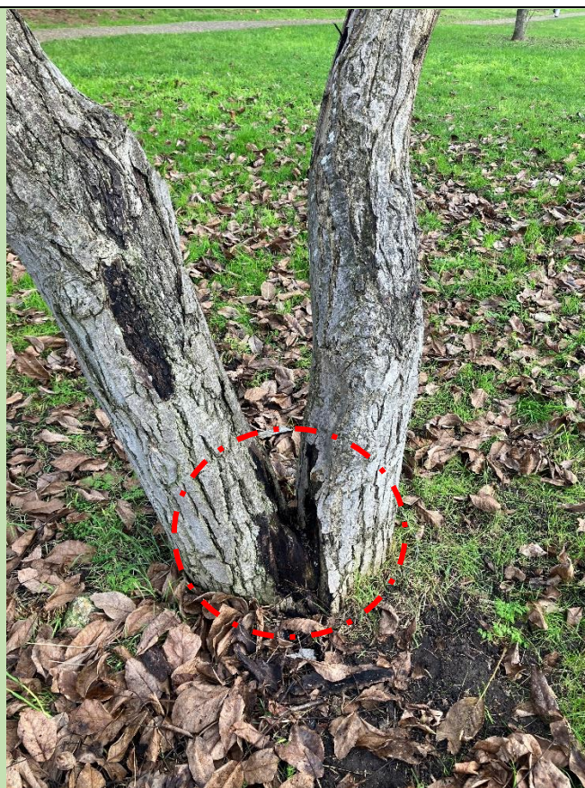
Figure 1_Zone de faiblesse structurelle
