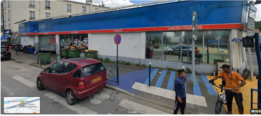
Vue depuis la RD933 (avenue de Paris – rue Jean Lolive)
