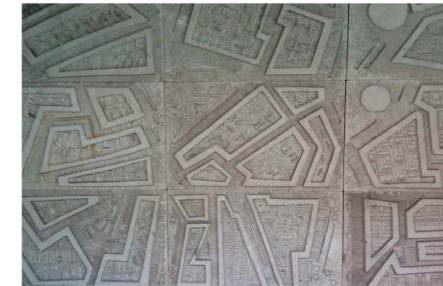
Mur en béton moulé, lavé et sablé - Denis Morog
