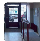
B Rampe améliorant l'accessibilité pour aux normes PMR
