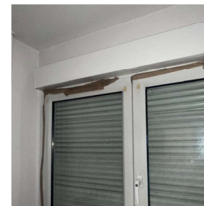
MENUISERIES EXTÉRIEURES NON ÉTANCHES
