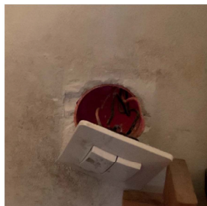
PRISES ET INTERRUPTEURS ARRACHÉS
