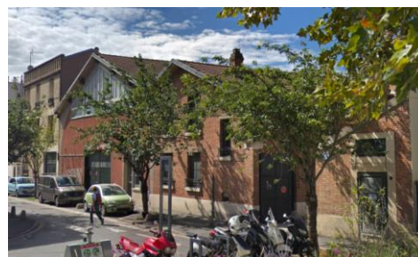
Usine Cuprotube, les Lilas – Source : google
