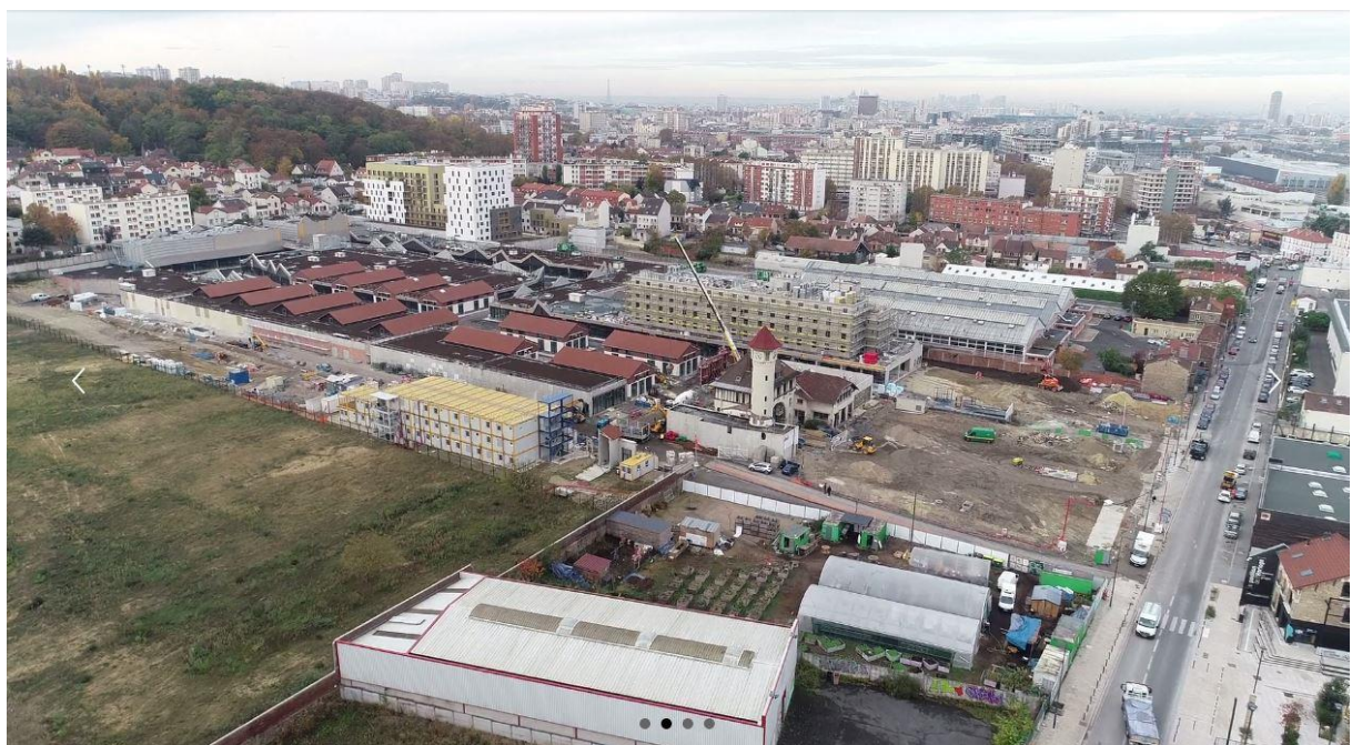
Vue aérienne du Village de Marques (Paddock Paris) en construction, 2018
