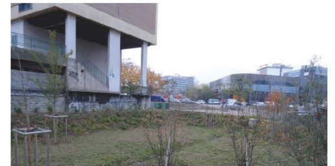
A la Noue, le bassin de rétention réalisé pendant l'ANRU 1
