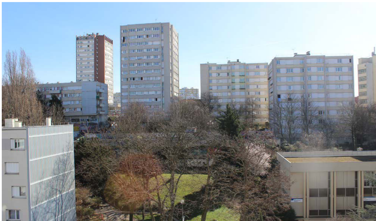
Les barres et les tours du secteur Sadi-Carnot rue de la barre aux Malassis
