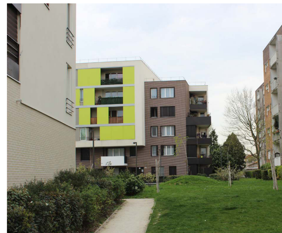
Les nouvelles constructions des Malassis rue Curie à Bagnolet
