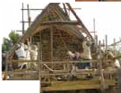
a. Fabricant et restaurateur de charpentes Photo © Tony Marchal
