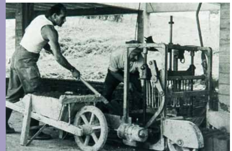
Durant leur temps libre, les hommes s'emploient à la construction du bâtiment, assumant l'ensemble des tâches du chantier. Les femmes contribuent à la logistique générale.
